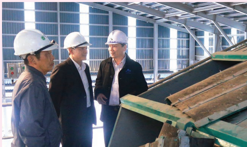
Đồng chí Dương Quốc Hùng, Trưởng phòng Xây dựng cơ bản cùng đồng chí Nguyễn Thành Công, Phó TGD Công ty kiểm tra tiến độ lắp đặt thiết bị dự án xây dựng dây chuyền NPK4
