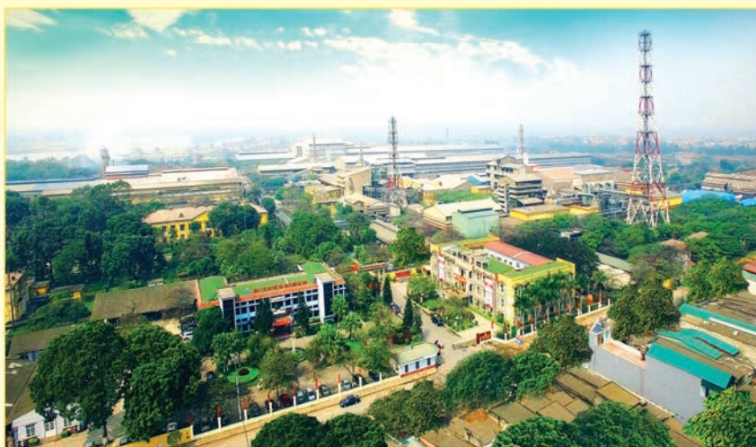
Diện mạo toàn cảnh Khu sản xuất và điều hành của Công ty CP Supe PP&HC Lâm Thao hiện nay
